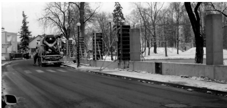
Il. 33. Budowa ogrodzenia parku miejskiego styczeń 2013 r. 54
