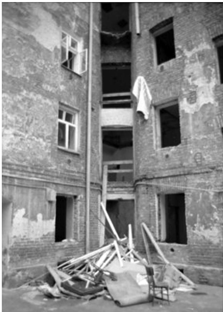
Il. 8. Przygotowania do remontu kamienicy przy ul. Wilczej 72.
