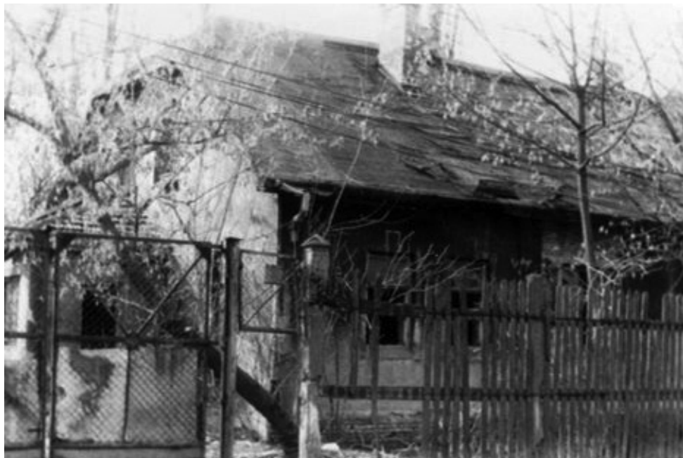
Il. 5. Opuszczony dom przy ul. Prądyńskiego 9, zbudowany przed 1935 r., rozebrany ok. 2009 r.
