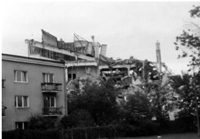
Il. 9. Rozbiórka Zakładów VIS S.A. – widok od ul. Ordona, z lewej kamienica przy ul. Ordona 7. W miejscu fabryki zbudowano Osiedle Bliska Wola.
