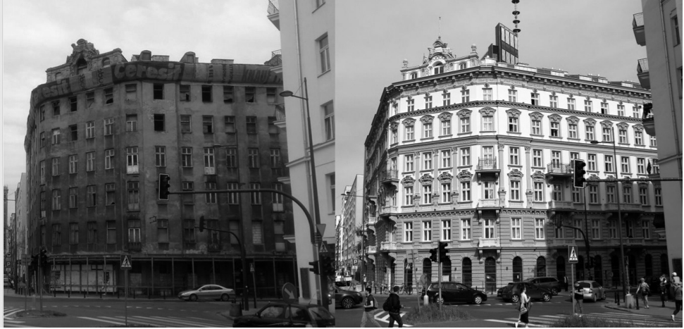
Il. 12. Kamienica w 2016 r. zabezpieczona po pożarze poddasza i z prawej po remoncie w 2022 r.
