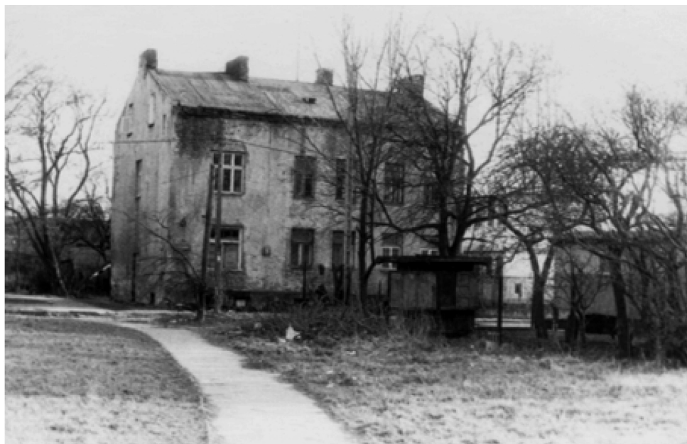
Il. 2. Dom przy ul. Wschowskiej 9, rozebrany w 2009 r., dziś w tym miejscu stoi blok przy ul. Ordona 12E.
