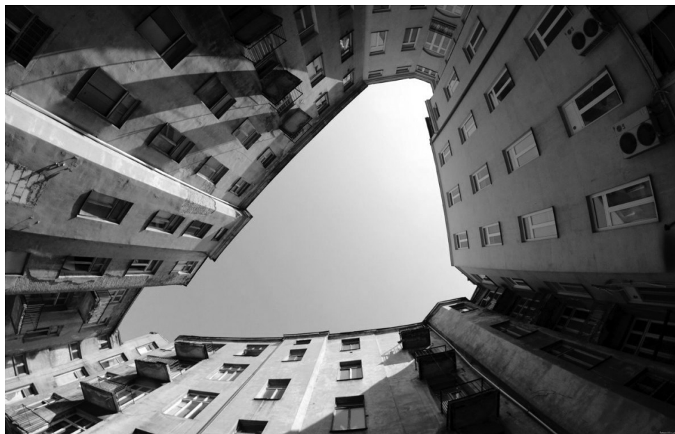
Il. 15. Podwórko kamienicy Lejba Osnosa przy ul. Twardej 28 – z prawej dobudowane na początku lat 90. nowe skrzydło przy ul. Twardej 30, mieszczące m.in. Dyрекcję Eksploatacji Cystern (rozebrane w 2019 r.).
