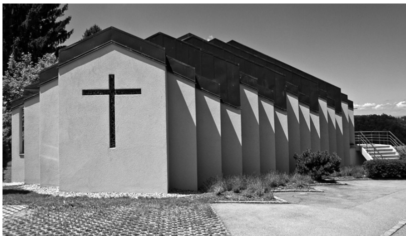
Il. 1. Siedziba Polskiej Misji Katolickiej w Szwajcarii w Marly k. Fryburga (2022 r.). Widok kaplicy wybudowanej w latach 1962-1967. Fot. A. Wojciechowska.
